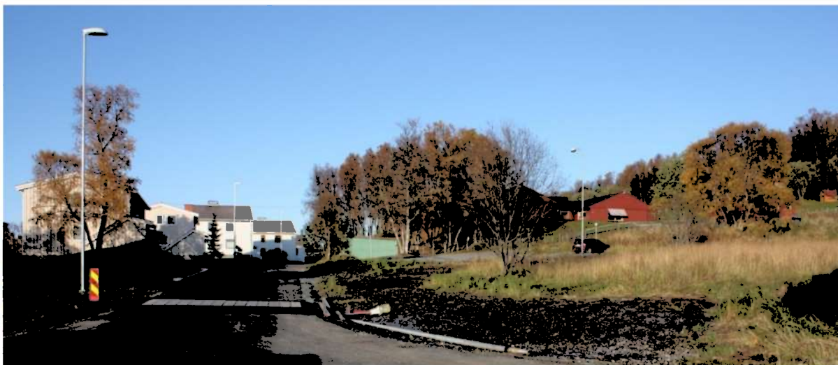
Nylig opparbeidet Lars Eriksens veg. Snarvei fra LE veg til lysløypa.
