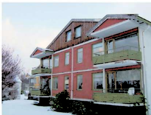
Fasade mot fjorden Foto: Leif Maliks, Forsvarsbygg.
